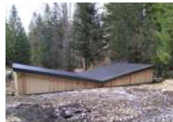
Un nouveau toit pour la citerne de la Blonay
