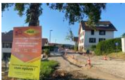
Après la réfection des réseaux, la voirie accueillera une liaison douce
